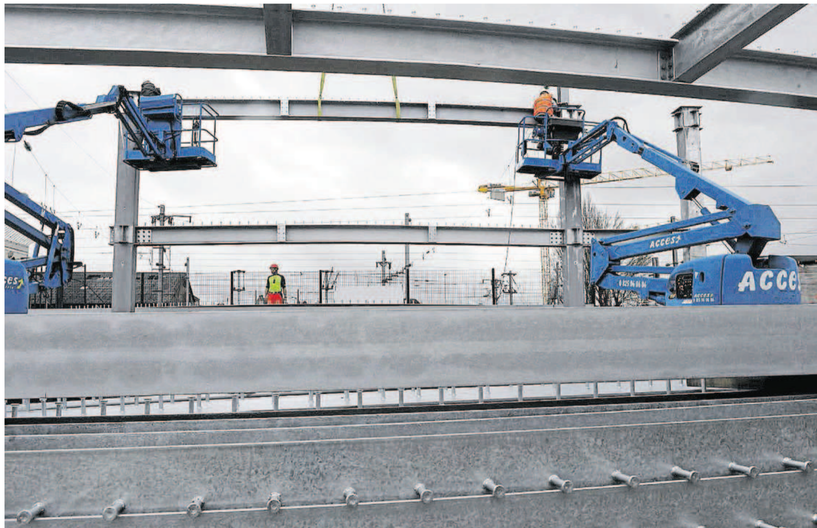
Angers, hier. Le chantier du parking « Saint-Laud II », haut de 26 mètres, ressemble pour le moment à un jeu de construction. Une quinzaine de personnes assemble la charpente métallique qui soutiendra l'ensemble de sept étages. Photo CO - Laurent COMBET.
