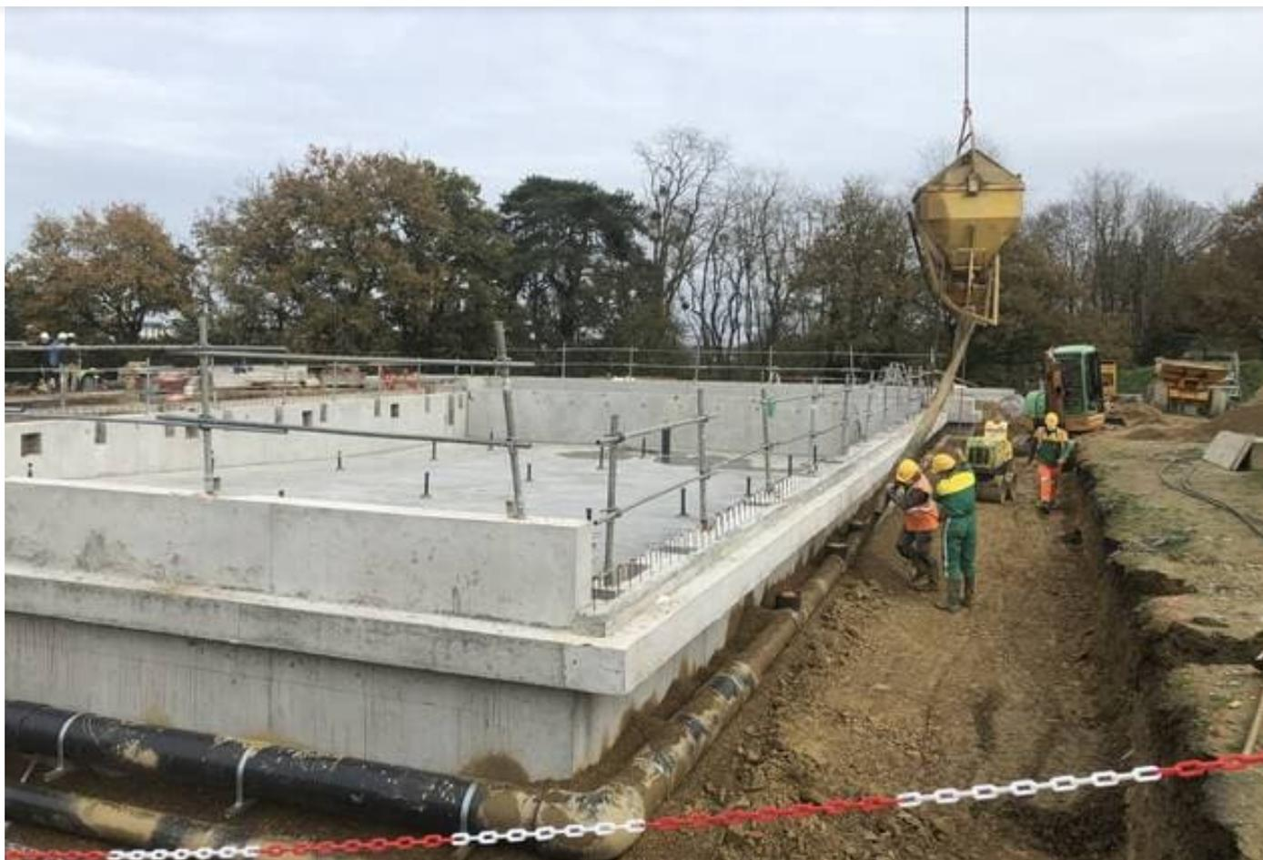
Les ouvriers se consacrent actuellement aux réseaux, avant la pose d'un revêtement en inox polymérisé dans le bassin. | CO
